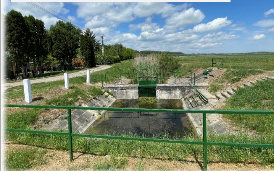
Ebtófoki szivattyútelep környezete
