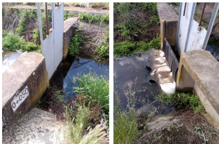
Reptér-II.-csatorna 0+050 km zsilip (alvízi) (felvízi)
