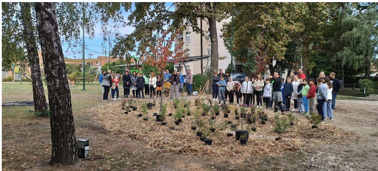
13. ábra Városháza melletti esőkert építés a Kisteleki Általános Iskola és a Városháza munkatársainak részvételével
