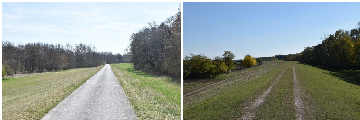
23. ábra: Jó minőségű burkolattal ellátott árvízvédelmi töltés (Duna-mente, Fajszt) / Burkolatlan töltés (Szalkszentmárton–Dunavecse)
