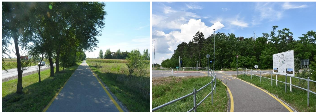
22. ábra: Kerékpárút Kecskemét–Városföld, illetve Tompa–országhatár között
