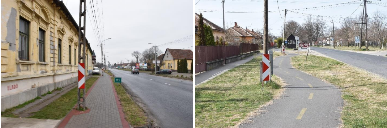
92. ábra: Villanyoszlop miatti szűkületek (Kiskunfélegyháza) / Villanyoszlopok miatti szlalomozás (Kunfehértó)
