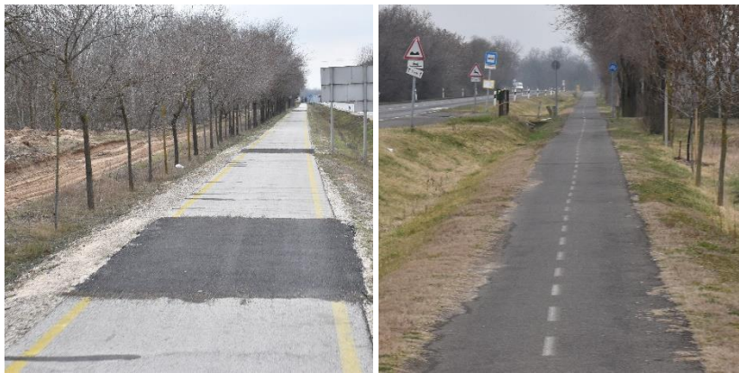
21. ábra: Különböző építési, karbantartási, fenntartási hiányosságokkal küzdő létesítmények (gyökérfelnyomódás, növényzet ránövése)
