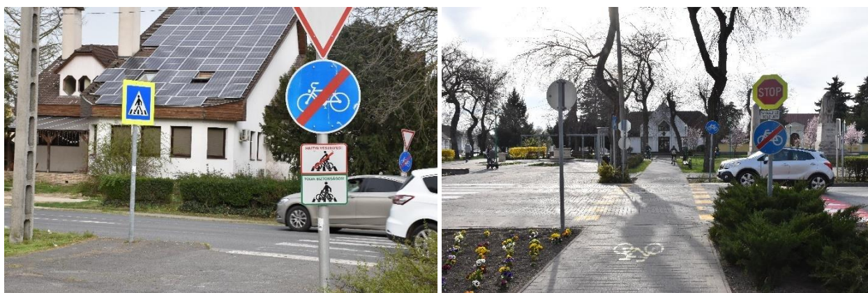
91. ábra: Átvezetés kialakítása helyett a gyalogátkelőn a kerékpározók leszállásra való felszólítása (Kalocsa) / Szintben kiemelt kerékpárút-átvezetés kerékpárút vége táblával és leszállásra való felszólítással (Kiskunhalas)
