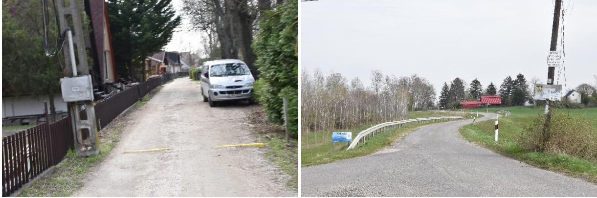
27. ábra: Stabilizált út a Ráckevei-Duna partján / 51114 sz. út
