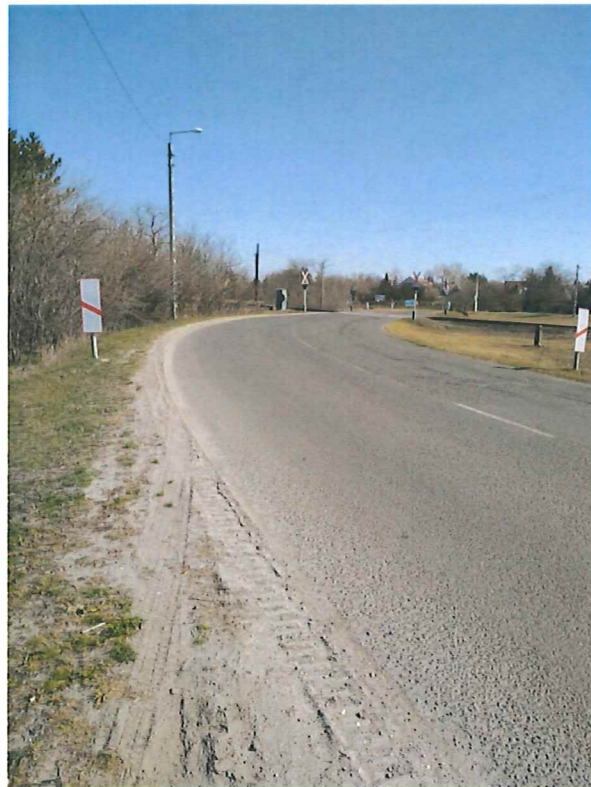
Árpádszállási út vasúti átjáró
