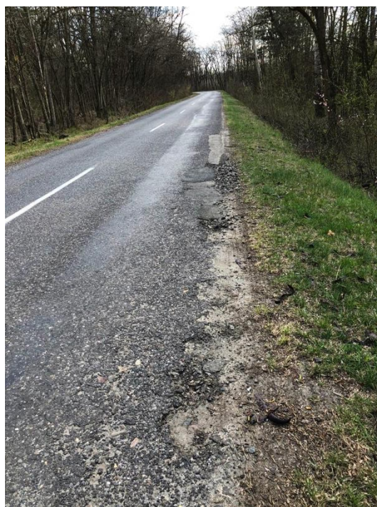
fotó: Útburkolat felületi kátyúzás és szélesítés tönkremenetelének látképe
