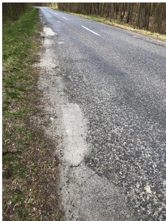
fotó: Útburkolat felületi kátyúzás és szélesítés tönkremenetelének látképe
