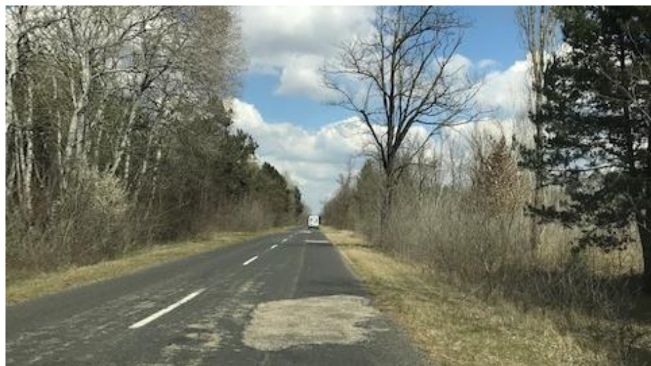
fotó: Útburkolat felületi kátyúzás látkép
